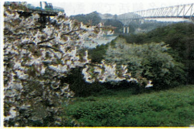
天草五橋「一号橋」
